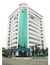
Cty CP Xây lắp TT Huế
