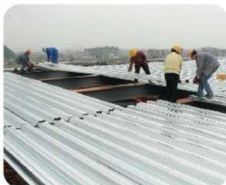
THI CÔNG MÁI TÔN
