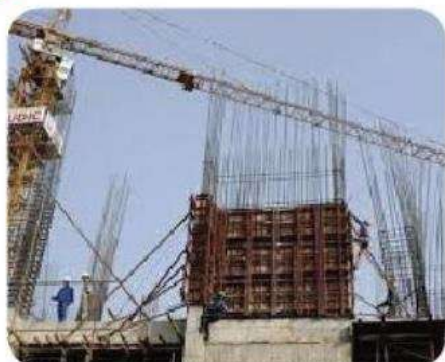
THI CÔNG CÔNG TRƯỜNG
